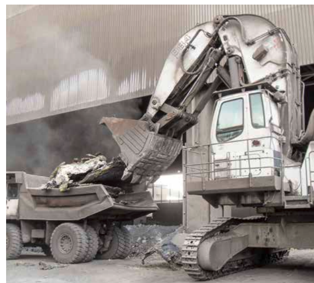
DILLIDUR: Miningbagger im rauen Einsatz
